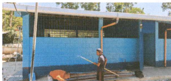
Foto 12: Pintura en muro exterior e interior
