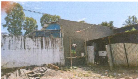
Foto 1: Repello en muro
