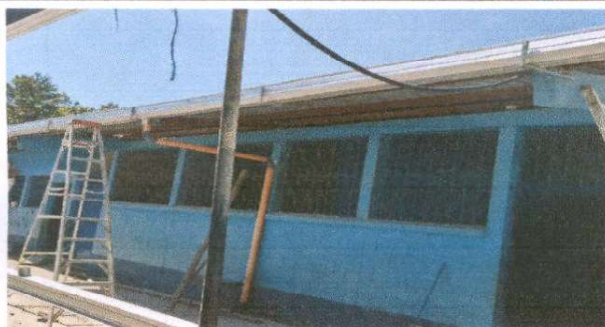
Foto 9: Sustitución de canales de metal.
