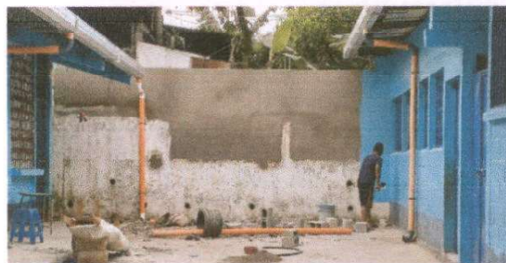
Foto 8: Reparación de muro perimetral de block.
