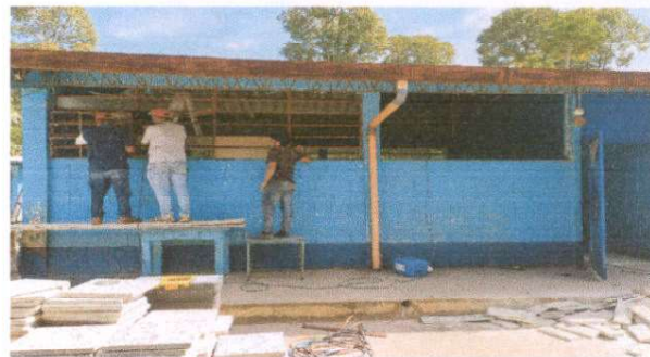
Foto 2 : Fabricación e instalacion de balcones de hierro en ventana.
