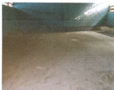
Foto 5: Sustitución de piso de cemento liquido (por piso de granito).
